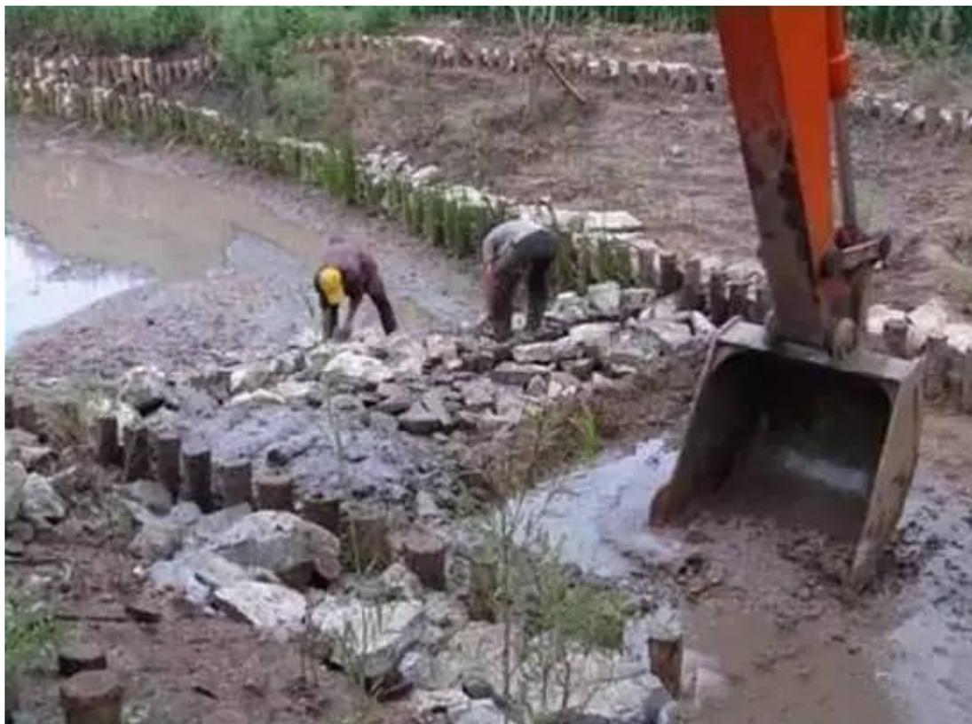
图5.3-10 生态跌水工的施工图
