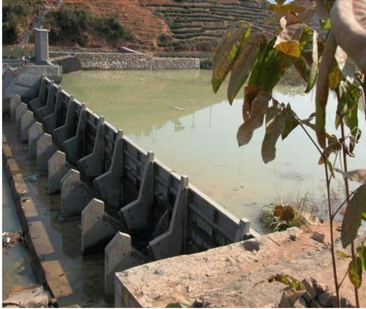
图 4.3-1 水力自动控制翻板闸示意图
