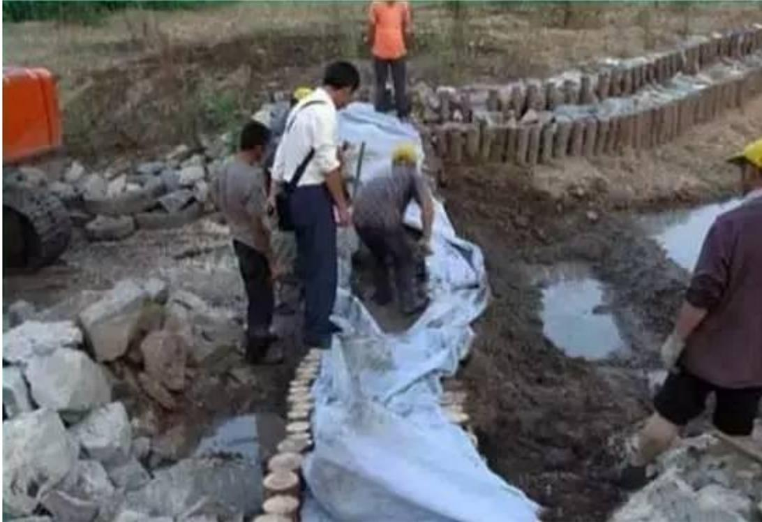
图5.3-17 铺设无纺布、填充沙土
